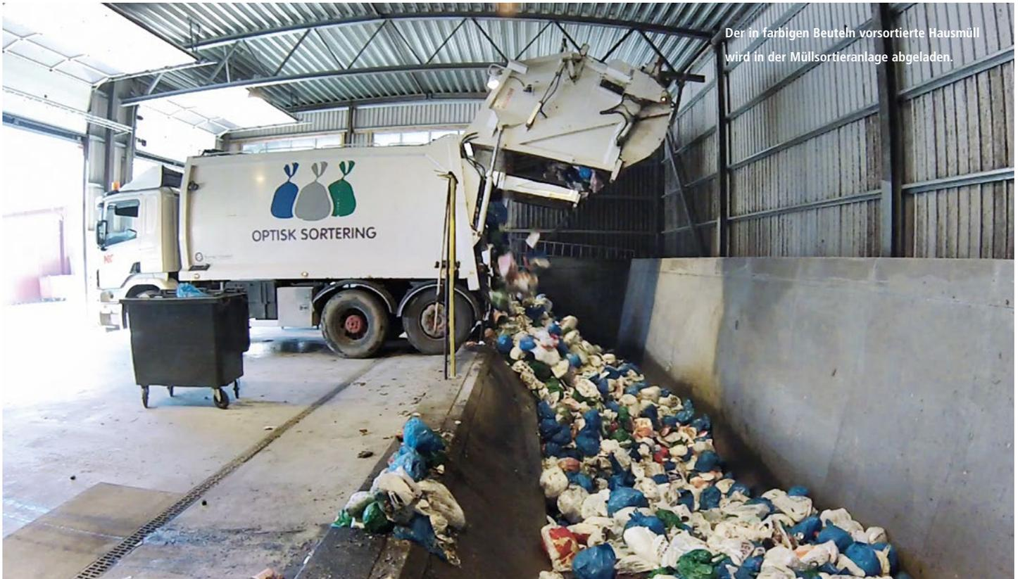
Der in farbigen Beuteln vorsortierte Hausmüll wird in der Müllsortieranlage abgeladen.
